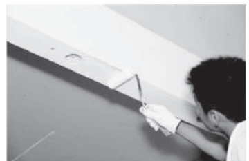
下地処理後、エマルジョンシーラーを 下塗り
