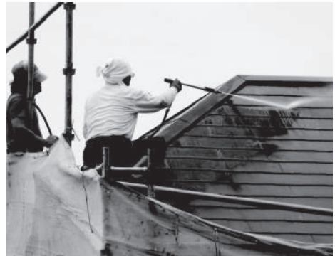
高圧洗浄によって汚れ等を除去
