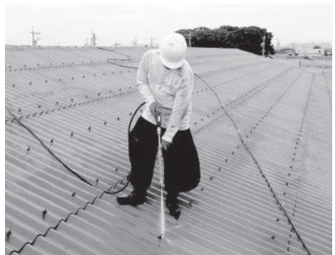
高圧洗浄によって汚れ等を除去
