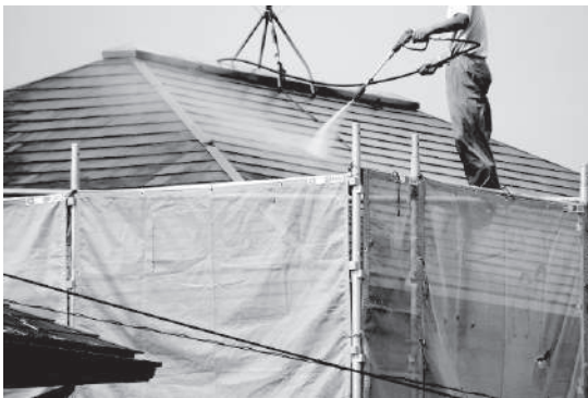
高圧洗浄によって汚れ等を除去
