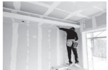
張り替えたボードに、パテで下地処理をする。
