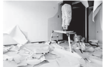
既存の内装材は、きれいに剥がす必要がある。
