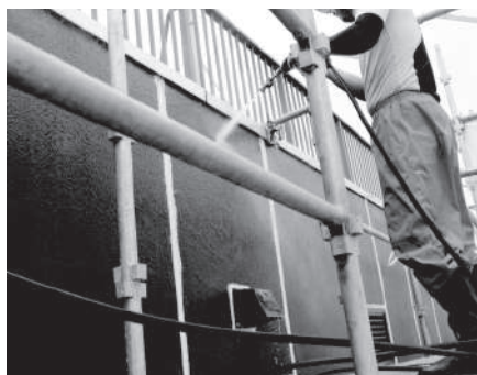
高圧洗浄によって汚れ等を除去
