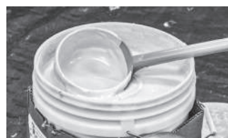
3分程度、十分に攪拌を行うと塗料の 質感が滑らかになる
