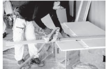
必要に応じて、クロスやボードを張り替える。
