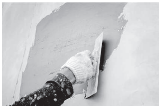
多孔質下地は目止め作業が必要
