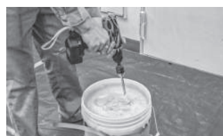
攪拌する際は必ず攪拌機を使用する
